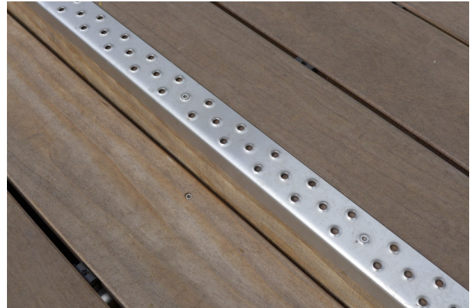
Abb. 2: Beispiel für einen mechanischen Rutschhemmer (profilierter Blechstreifen) an einer Stufenvorderkante
